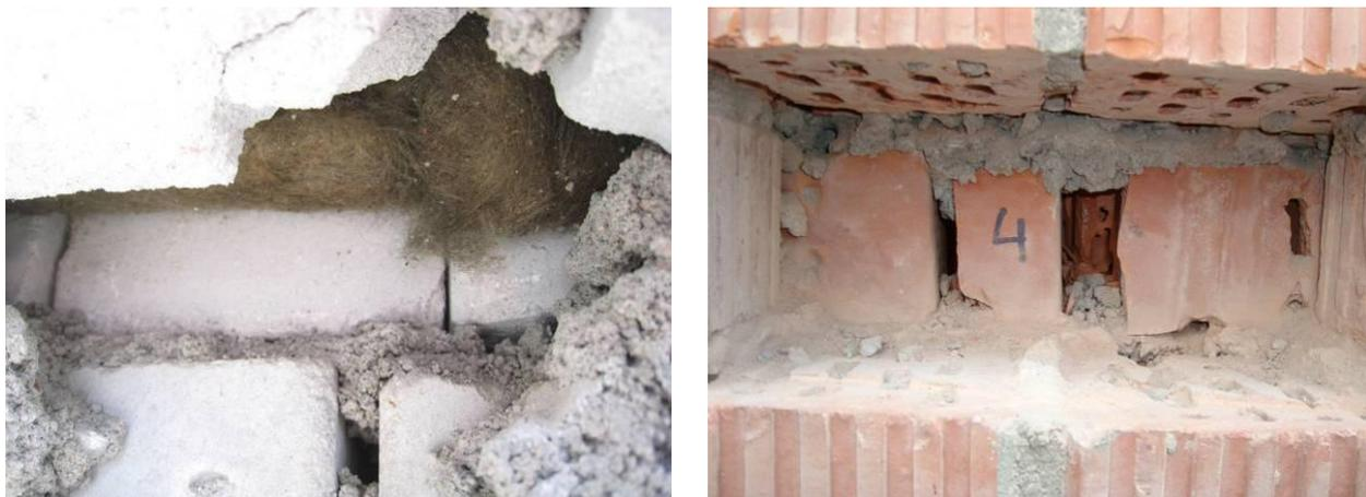
Рисунок 2.16 Небрежно сложенная несущая стена: не заполненные раствором вертикальные швы, хаотическое соединение, одиночные камни и пр.
