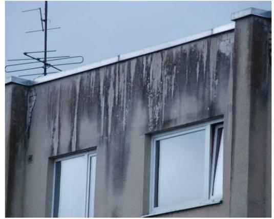
Рисунок 2.26 Течь крыши (слева) и стекшая с крыши вода могут повредить часть стены верхних этажей.
