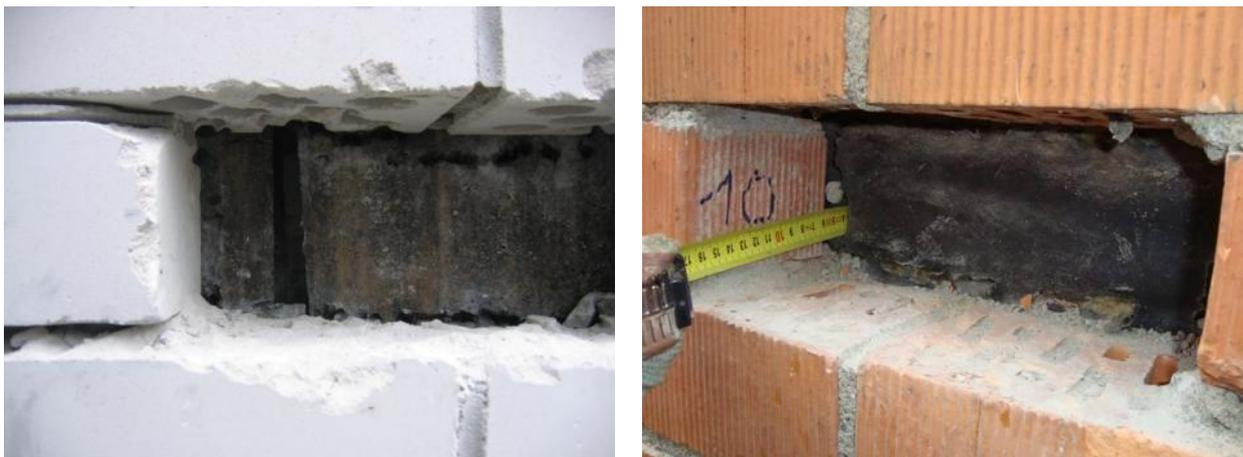
Рисунок 2.2 Между кирпичным фасадом и утеплителем может быть слой толя или рубероида.
