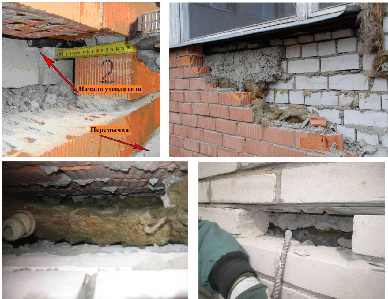
Рисунок 2.20 Отсутствующая теплоизоляция в кирпичном доме.
