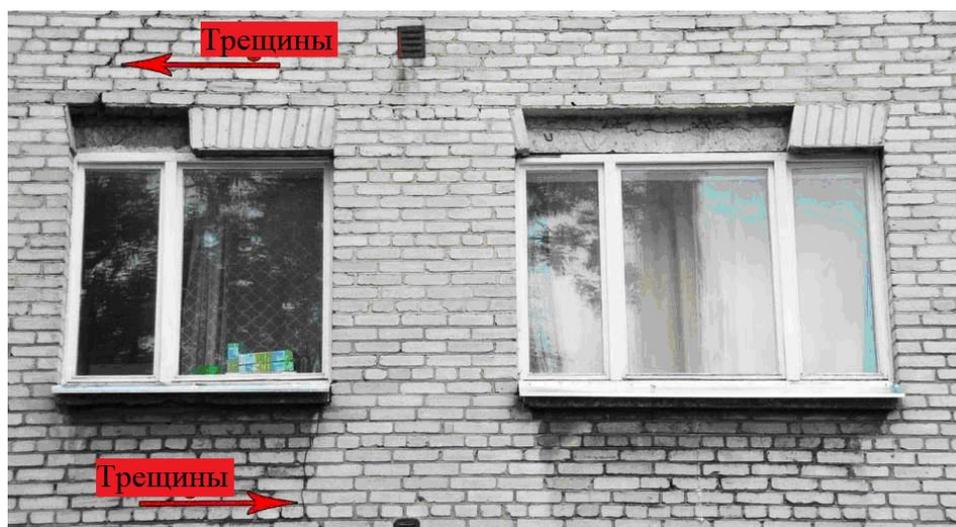
Рисунок 2.17 Развалившиеся перемычки, щели и кирпичи, поврежденные из-за отсутствия жестяного отлива стены.
