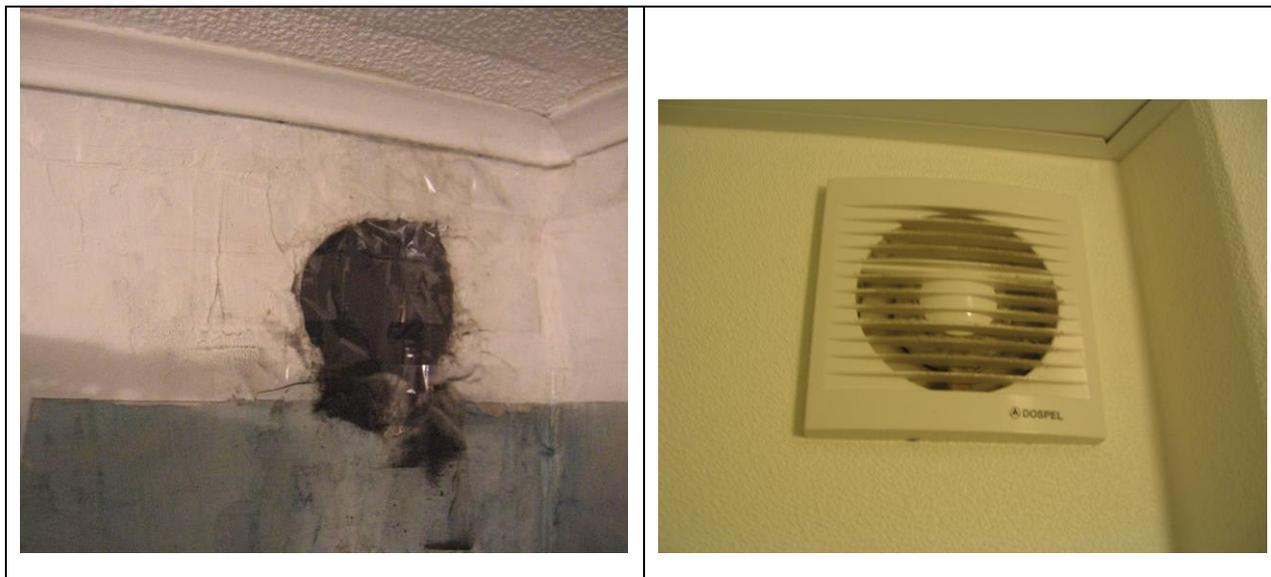
Рисунок 10.6 Вытяжные отверстия испорчены (слева) и новый установленный вытяжной вентилятор (справа).
