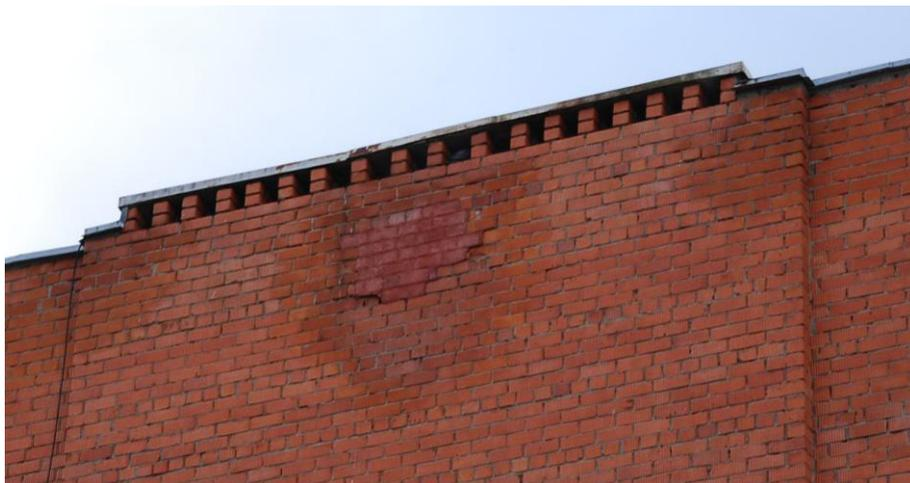
Рисунок 2.14 К разрушению фасадного кирпича может привести конденсируемый в верхней части вентиляционной трубы водяной пар и отсутствующие жестяные покрытия на трубе.
