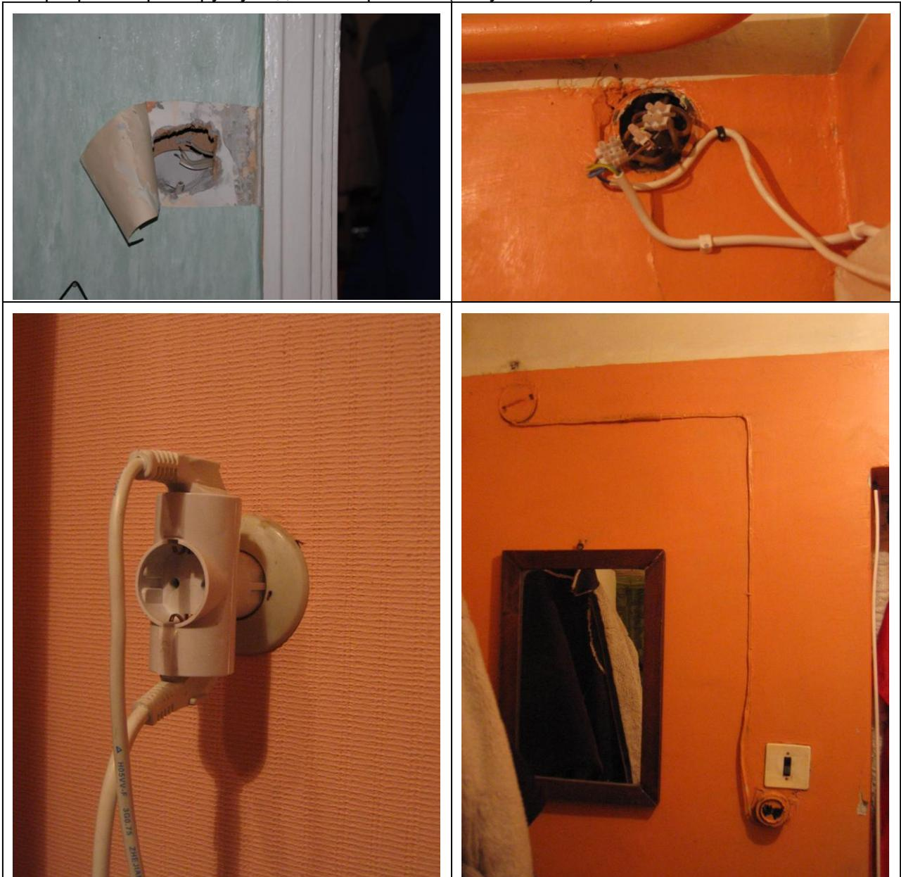
Рисунок 10.11 Наличие открытых электрокабелей в квартире (вверху) и перенагрузка розеток (внизу) очень рискованны с точки зрения электробезопасности.
