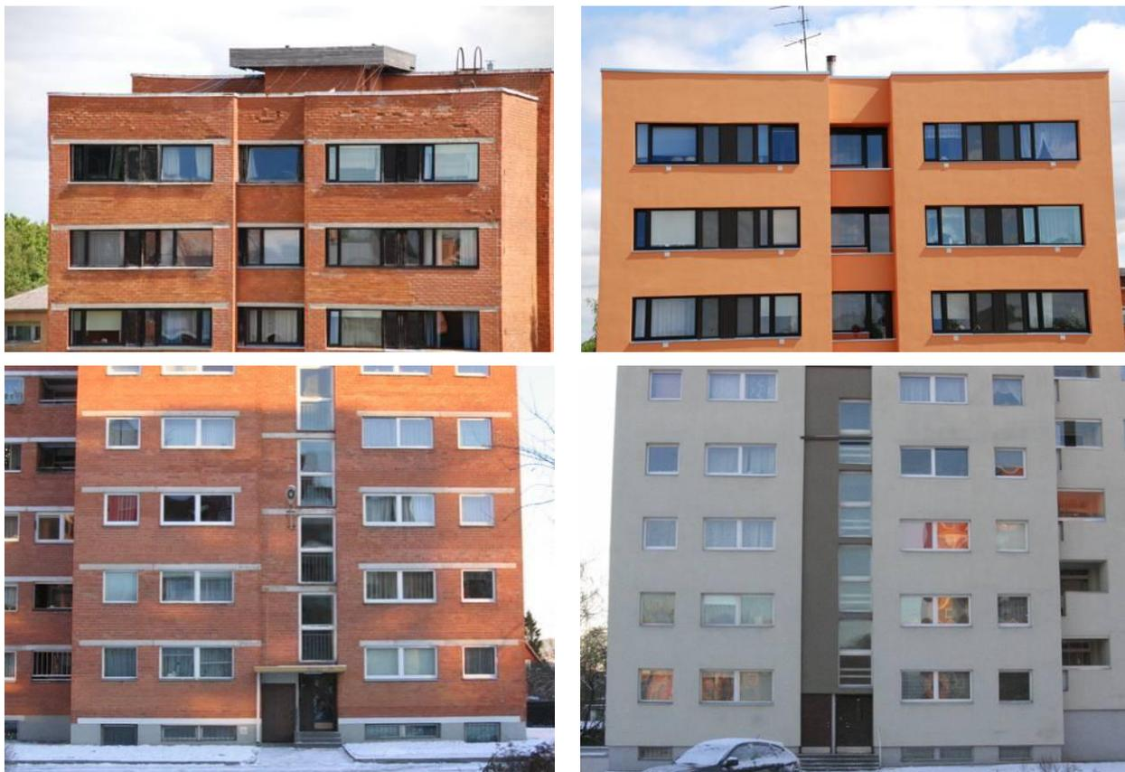
Рисунок 13.9 Дополнительная изоляция соседних домов: новое (справа) решение отличается от предыдущего (слева) лучшим техническим и архитектурным качеством.
