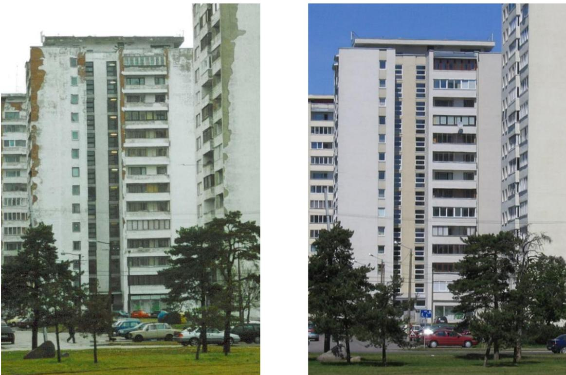
Рисунок 13.1 Кирпичный дом до (слева, 2002 г.) и после ремонта фасада (справа, 2009 г.).
