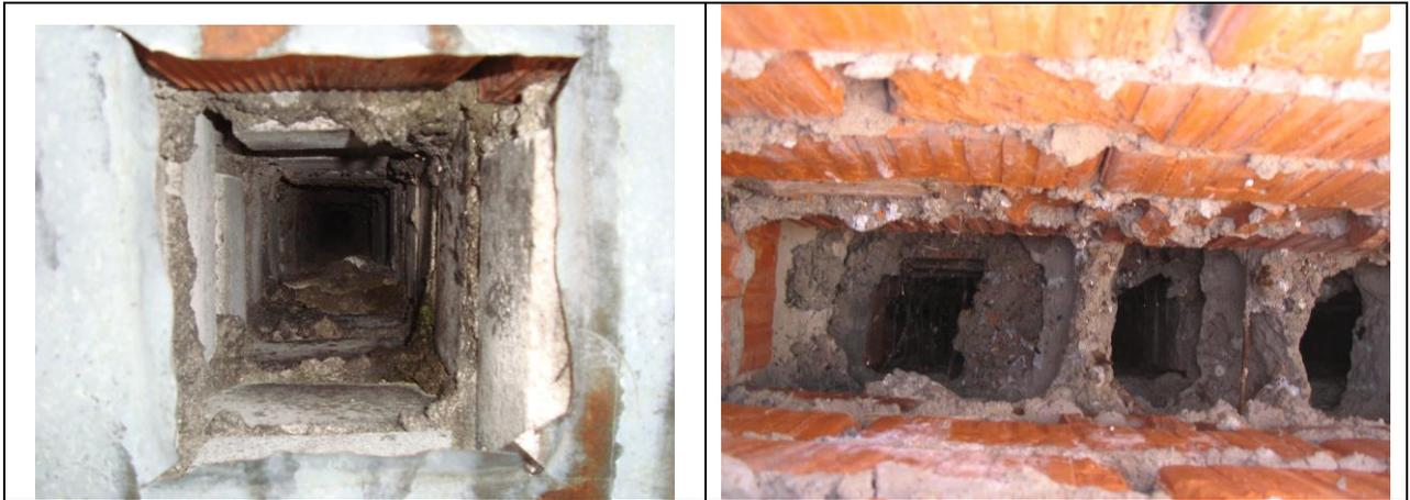
Рисунок 10.3 Качество строения вентиляционных каналов плохое, стены чересчур шероховатые (слева и справа).
