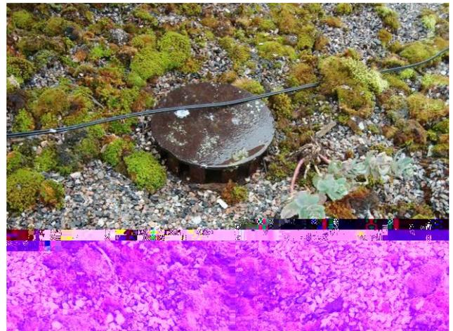
Рисунок 2.27 Конструкции крыши, поврежденные водой (слева). Растительность на крыше задерживает поток воды и повреждает покрытие (справа).
