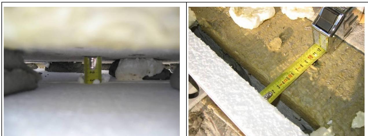
Рисунок 5.10 Некачественно установленная дополнительная изоляция: не использован клей в плоскости теплоизоляции и внешний воздух попадает в этот промежуток.
