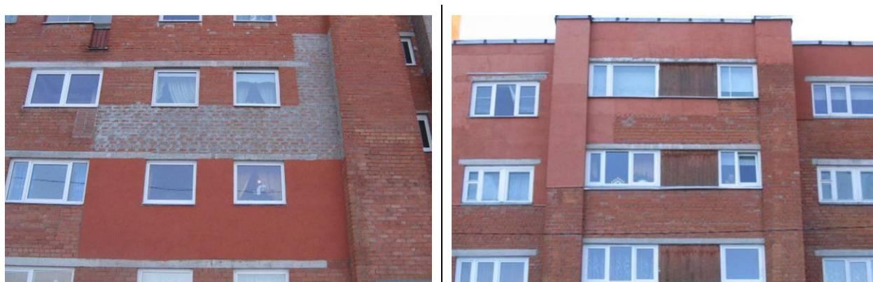
Рисунок 13.7 Оштукатуренная облицовка из керамического кирпича.
