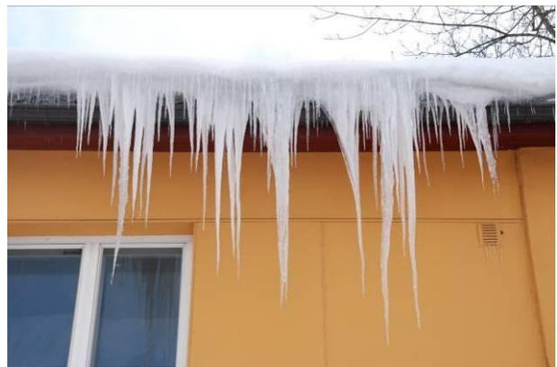
Рисунок 2.28 Сосульки на карнизе – верный признак отсутствия теплоизоляции на крыше.
