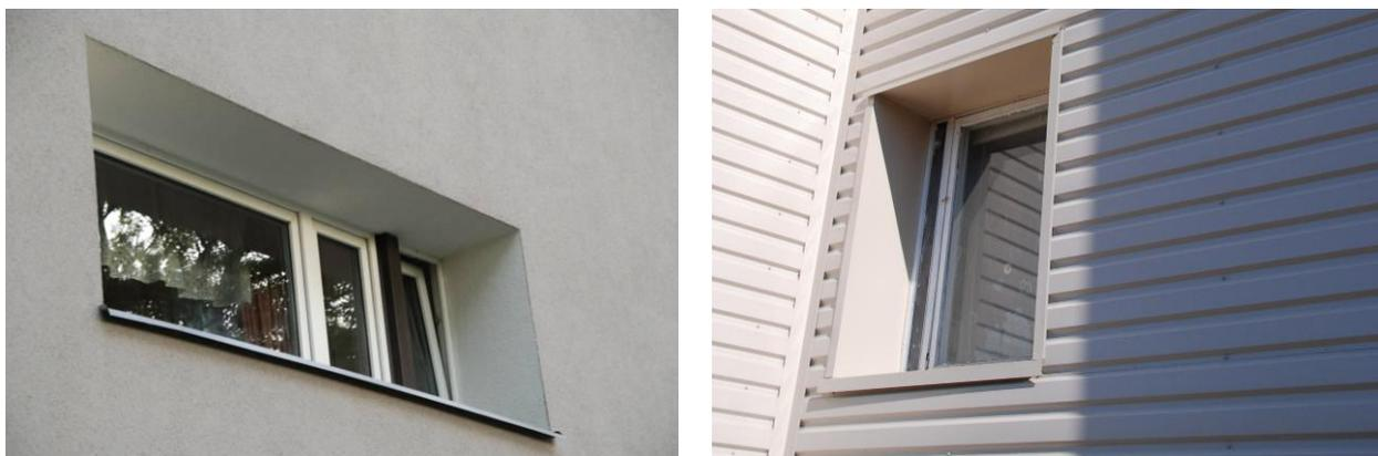
Рисунок 13.10. Чтобы избежать «дырок» окна при дополнительном утеплении, необходимо располагать окно ближе к внешней части внешней стены.
