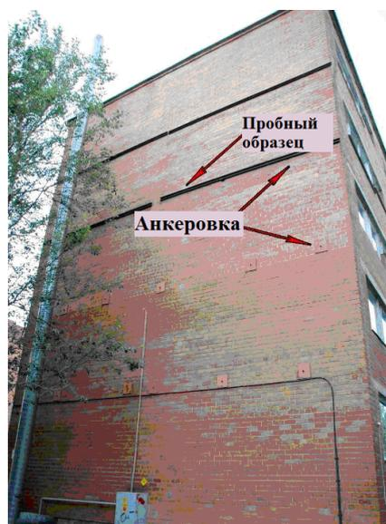
Рисунок 2.4 Разрушение перевязочного кирпича и облицовки примерно на 10 см с внешней стороны (слева). Для связи фасада со стороны несущей стены использованы анкера (справа).
