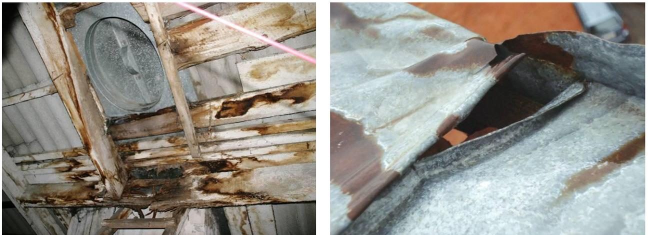
Рисунок 2.25 Типичные места утечек на скатных крышах в районе труб, люков и других отверстий в крыше (слева).
