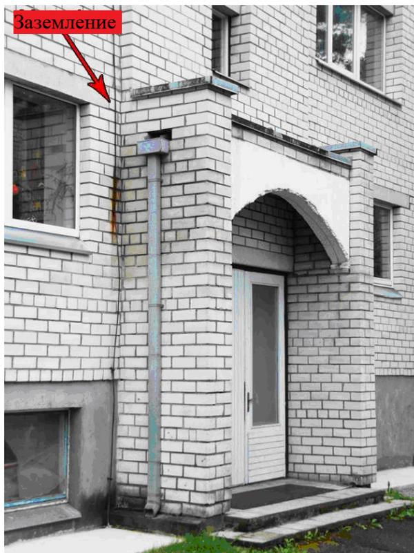
Рисунок 2.13 Вода, стекающая по кабелям на фасад – причина разрушения кирпичей.
