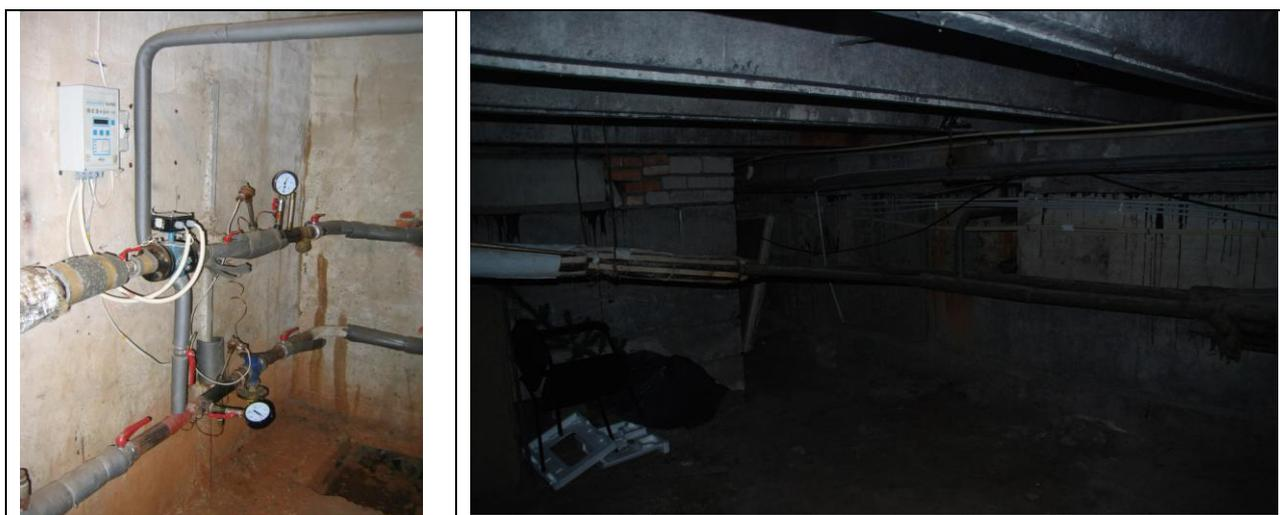
Рисунок 10.9 Отсутствует утепление отопительной трубы в подвале.
