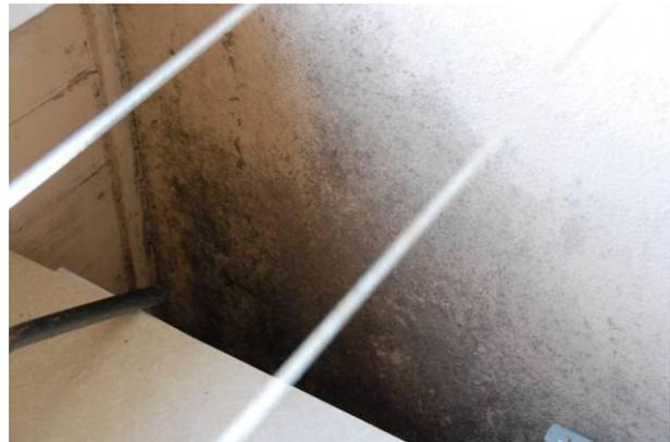
Рисунок 2.31 Рост плесени на внутренней стене лоджии.
