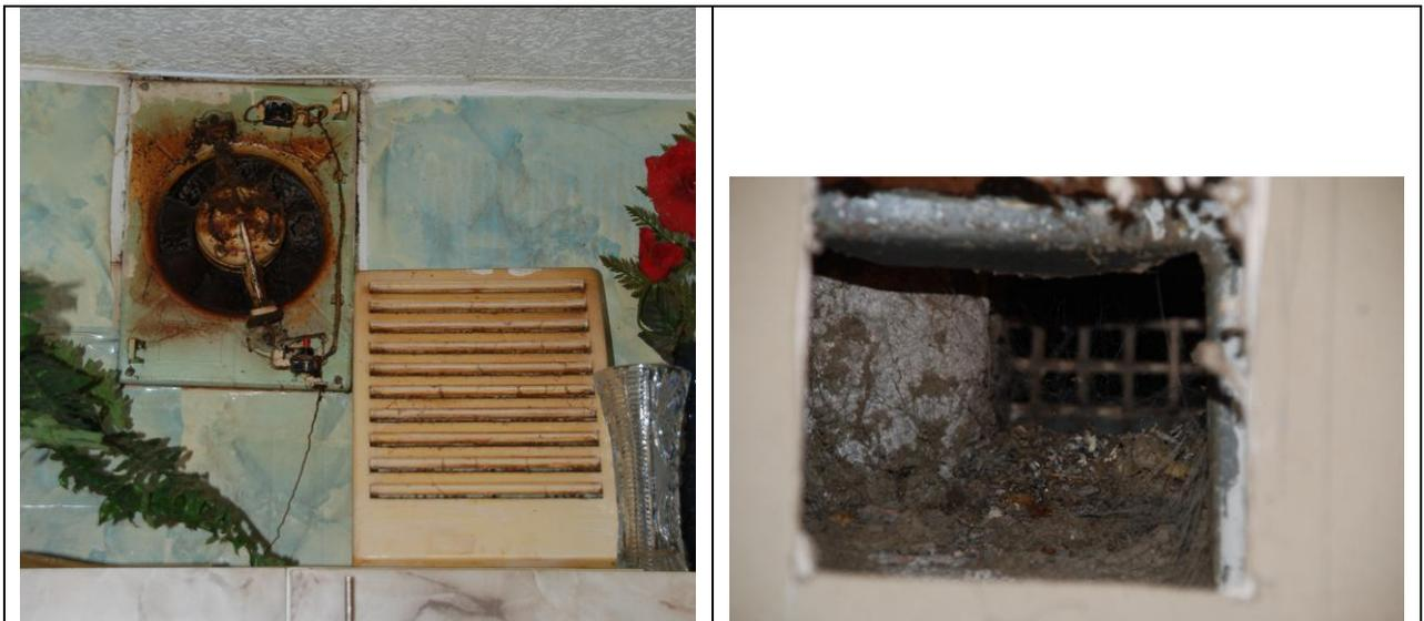
Рисунок 10.5 В вытяжках квартир годами скопленная грязь и пыль (справа) и неухоженное вентиляционное оборудование (слева).
