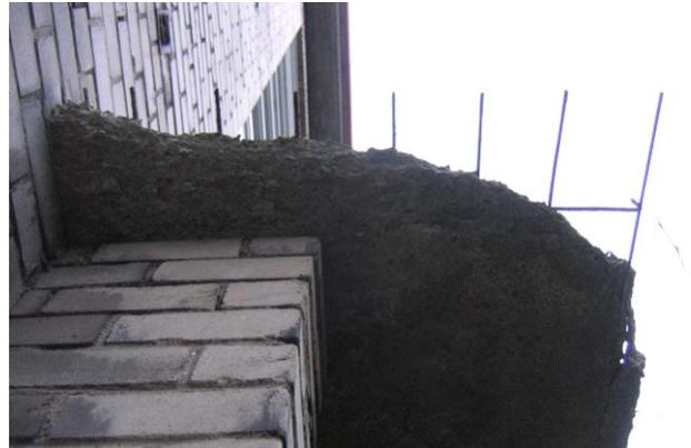
Рисунок 2.29 Расслаивающийся пол лоджии (слева) и навес у входа в подъезд (справа).
