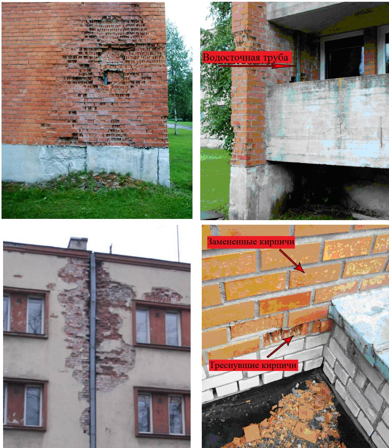
Рисунок 2.11 Большой вред стене может нанести утечка в водосточной трубе. Потерявший морозостойкость кирпич, который обновлен несколько лет назад (внизу справа).
