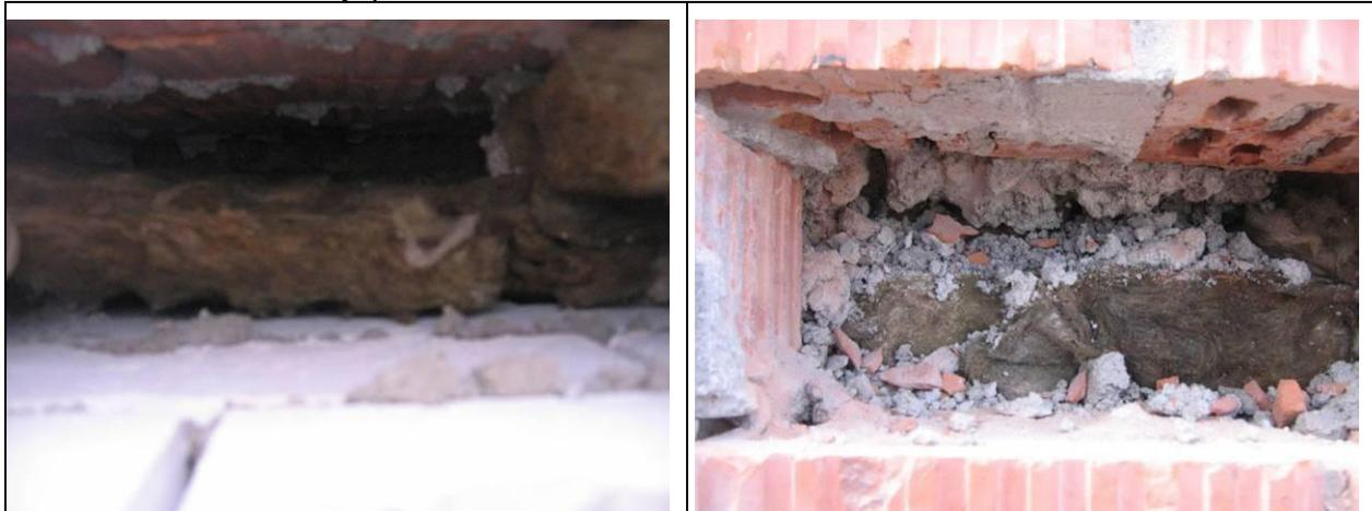
Рисунок 5.9 Теплопроводность стены увеличивается за счет движения воздуха в области теплоизоляции (слева), а также из-за ее отсутствия или наличия раствора вместо неё (справа).
