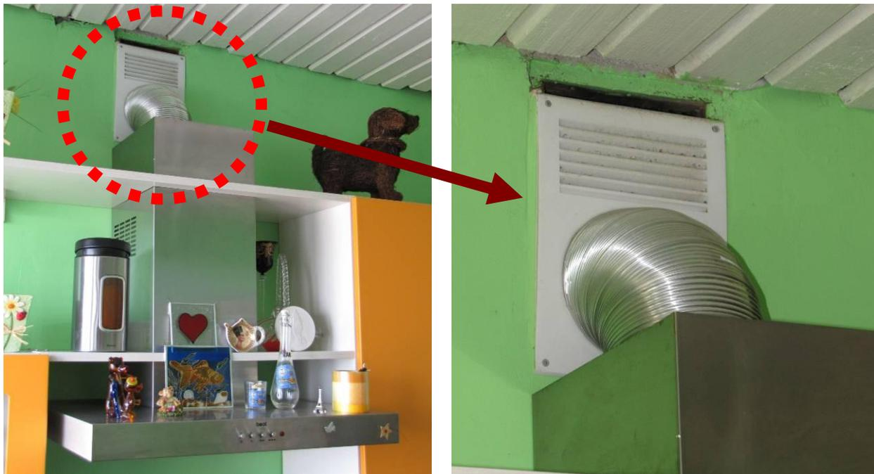
Рисунок 13.4 Решетка вентиляционного канала на кухне закрыта вытяжкой.
