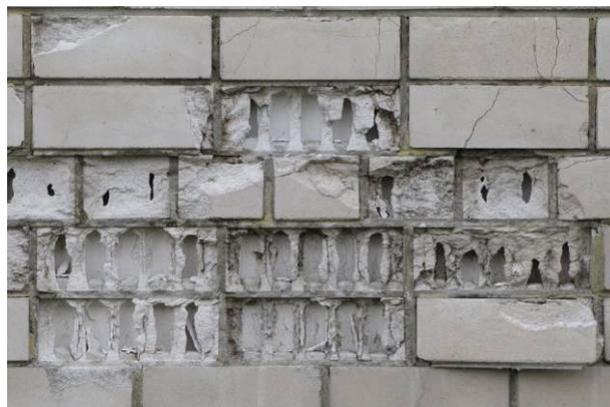
Рисунок 2.6 Поврежденная холодом облицовка из керамического кирпича (слева) и силикатного кирпича (справа).
