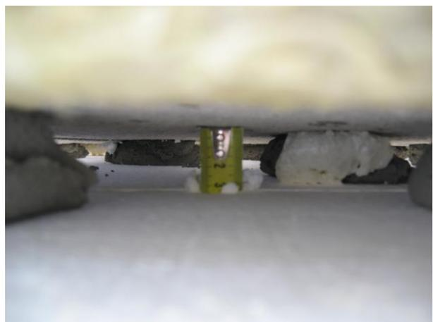
Рисунок 13.5 Некачественно установленное дополнительное утепление: на поверхности не использован клей и внешний воздух попадает на стену или на слой между стеной и утеплителем.
