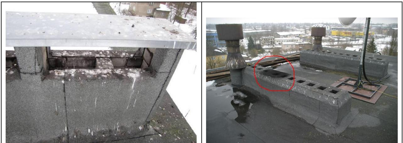
Рисунок 10.4 Птицы строят гнезда на вентиляционных трубах, потемнение воздушных каналов (справа) или использование труб не по назначению (слева).
