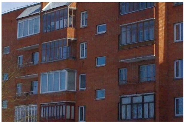
Рисунок 2.30 Произвольно остекленные лоджии и балконы.
