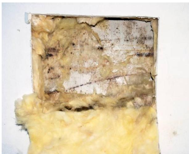
Рисунок 2.22 Дополнительная внутренняя изоляция стала причиной роста плесени внутри стены.
